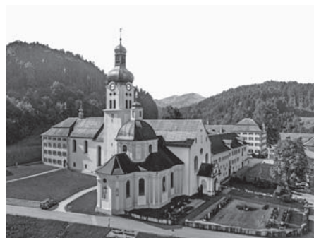
Bild: Standortförderung Züri Oberland, Marco Reichlin
